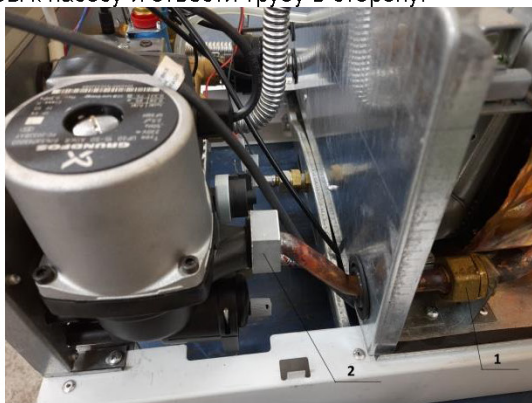
Рис. 20. Демонтаж трубы насоса
