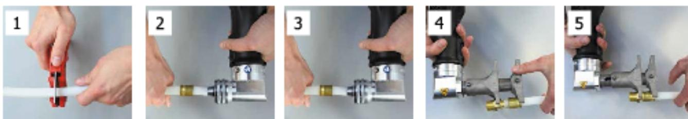
1. Трубу отрезать труборезными ножницами под прямым углом.
