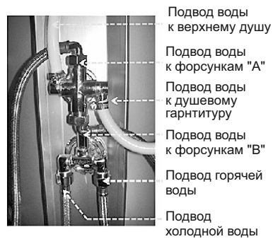
Детальное фото подключения подводки к смесителю
