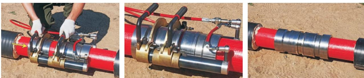
**Монтаж линейного стыка двухтрубной конструкции ТВЭЛ-ПЭКС с помощью гидравлического и ручного инструмента. Фитинговое соединение труб ТВЭЛ-ПЭКС-2 40+32/140 муфтами соединительными равнопроходными с монтажными гильзами.**
