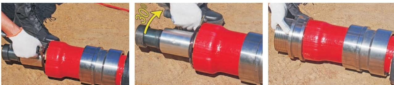
Вставить соединительную муфту в развальцованную трубу. Через небольшой промежуток времени труба плотно обожмет муфту. Установить инструмент на посадочные технологические проемы ровно, без перекосов. Используя инструмент осуществить запрессовку, т.е. перемещение гильзы до соприкосновения с муфтой.
