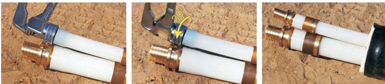
Вставить соединительную муфту в развальцованную трубу. Через небольшой промежуток времени труба плотно обожмёт муфту.
