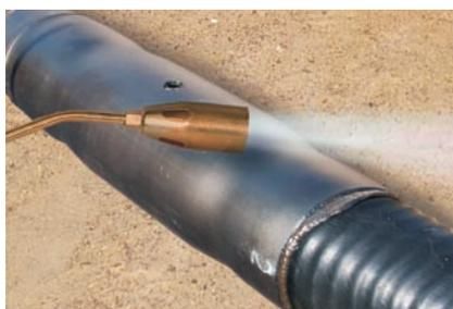
Обезжирить, зашкурить и прогреть газовой горелкой\* края оболочек труб. Нанести на них адгезивную ленту. Освободить термо-усаживающуюся муфту от упаковки и надвинуть на стык. Прогреть края муфты горелкой до полной усадки на оболочку. С помощью монтажного пенопакета осуществить заливку смеси компонентов ППУ через предварительное просверленное отверстие внутрь муфты. В течение нескольких минут смесь вспенится, заполнит область стыка и затвердеет. Заварить отверстие п/э пробкой.
