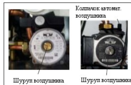
Рис. Воздушники на контуре
