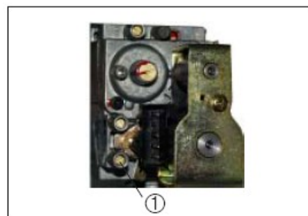
Рис.: Контроль давления подключения газа
