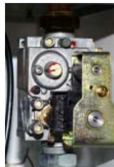
Рис.: Комбинированный газовый клапан Опасность поражения электрическим током Опасность отравления и взрыва в случае утечки газа
