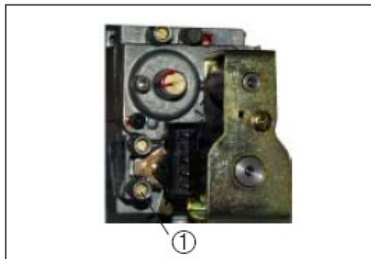
Рис.: Контроль давления подключения газа
