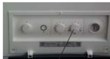
Установка на режим трубочиста
