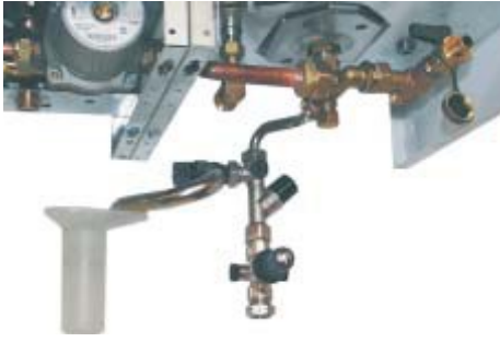
Рисунок: Оборудование, монтируемое открытым способом
