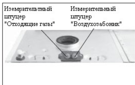
Рис.: Измерение отходящих газов на закрытом котле
