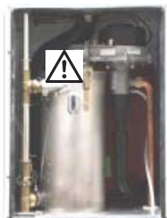
Рис.: Трансформатор поджига, электрод поджига, камера сгорания. Опасность поражения электрическим током, опасность возгорания из-за горячих деталей.
