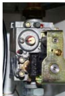
Рис.: Комбинированный газовый клапан Опасность поражения электрическим током
