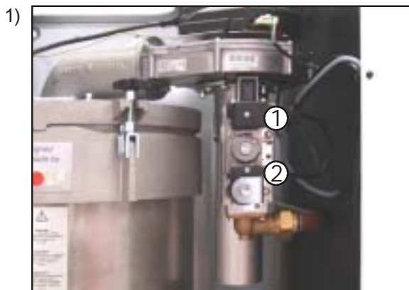
Отсоединить штекеры ①② (сначала открутить винты)
