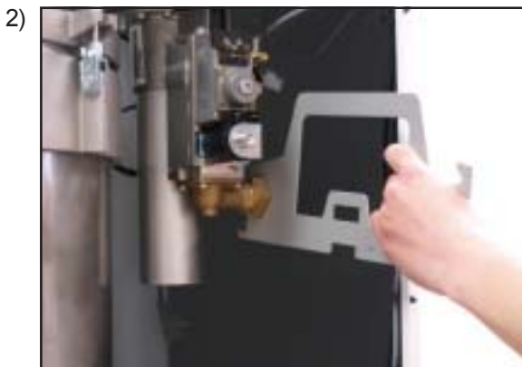
Осоединить подключение газа к комбинированному газовому клапану
