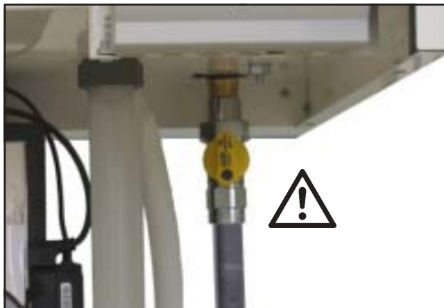
Рис.: Подключение газа Опасность отравления и взрыва в случае утечки газа
