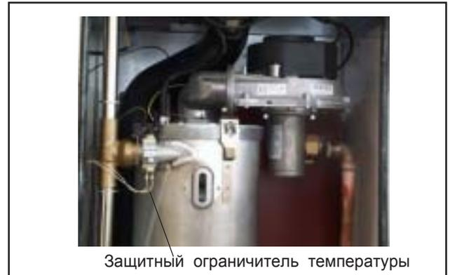
Рис.: Защитный ограничитель температуры
