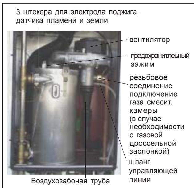
Рис.: Демонтаж горелки
