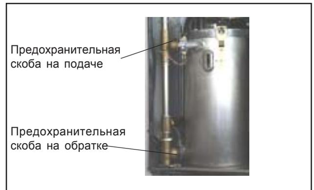
Рис.: Снять предохранительные скобы с подачи и обратки
