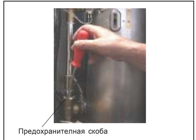
Рис.: Вытащить предохранительную скобу
