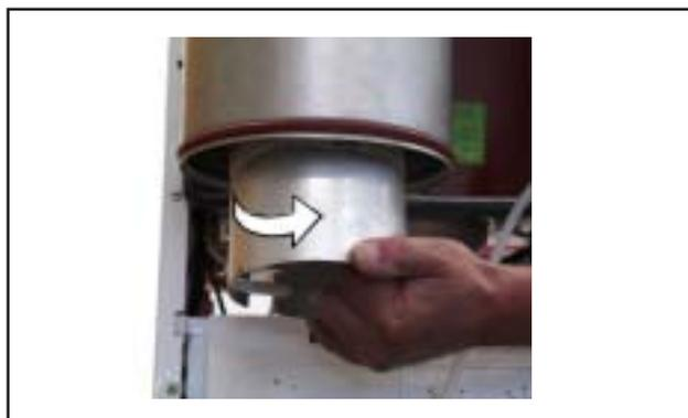
Рис: Выкрутить против часовой стрелки стакан камеры сгорания.
