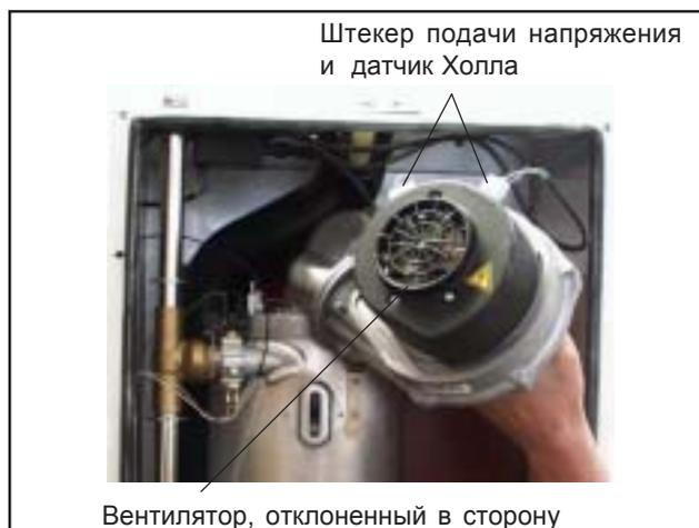
Рис.: Отклонить вентилятор в сторону
