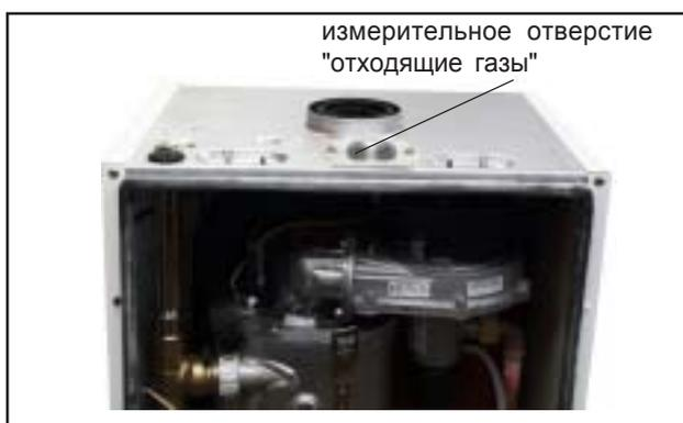
Рис.: Измерение отходящих газов на открытом котле
