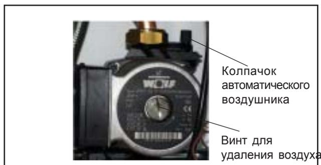
Рис.: Автоматический воздушный клапан на насосе котлового контура.
