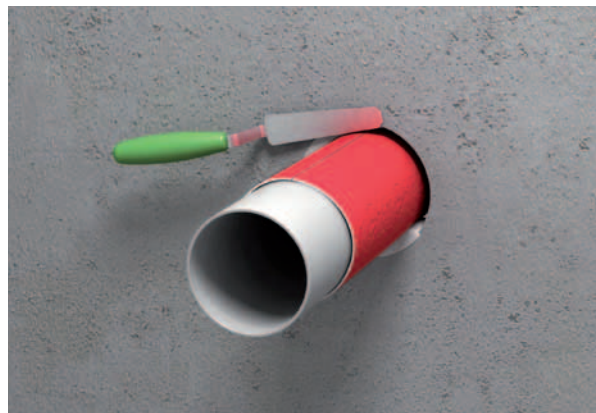
Герметично заделайте зазор для недопущения выхода дымовых газов
