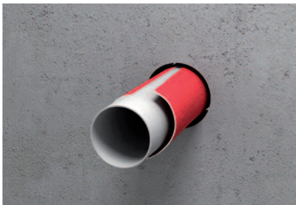
Выполните монтаж трубопровода (при необходимости вместе с поставляемым звукоизолирующим гибким кожухом)
