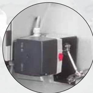
Электрический сервопривод для регулировки воздуха
